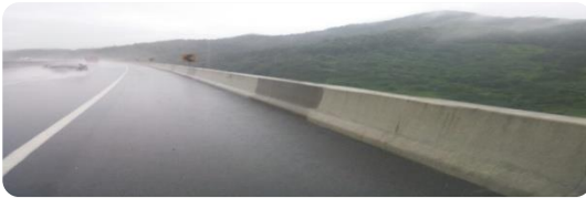
[고속도 분리대 점멸 시공]
